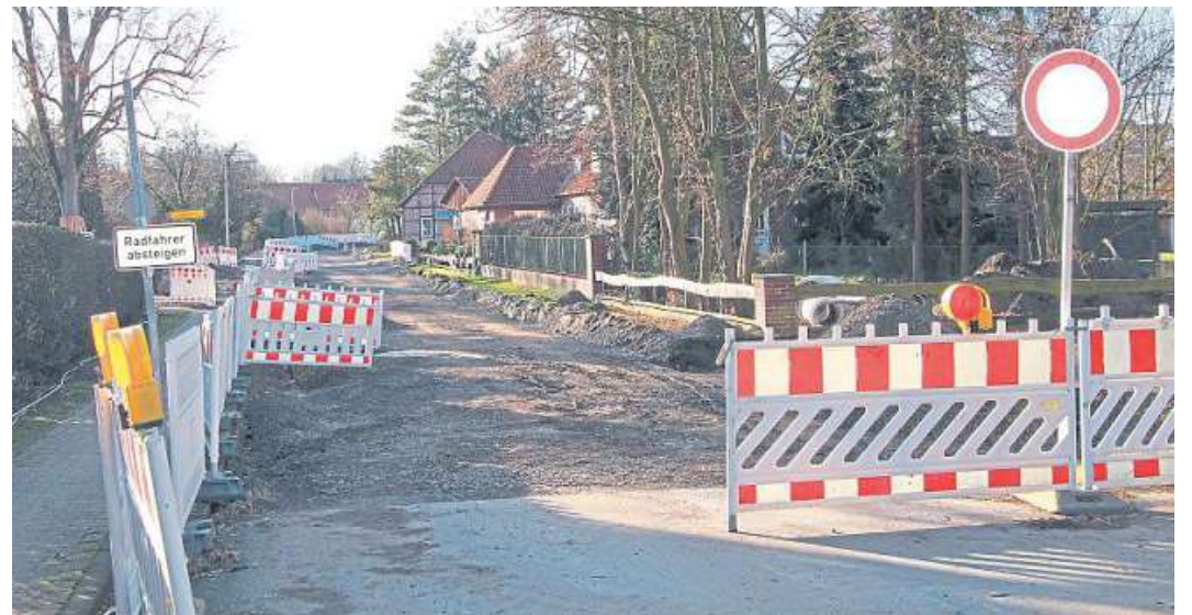
Die Baustelle der Ortsdurchfahrt von Stöckse ruht nicht. Zurzeit wird im zweiten Bauabschnitt der Regenwasserkanal verlegt und der Bürgersteig gebaut.
